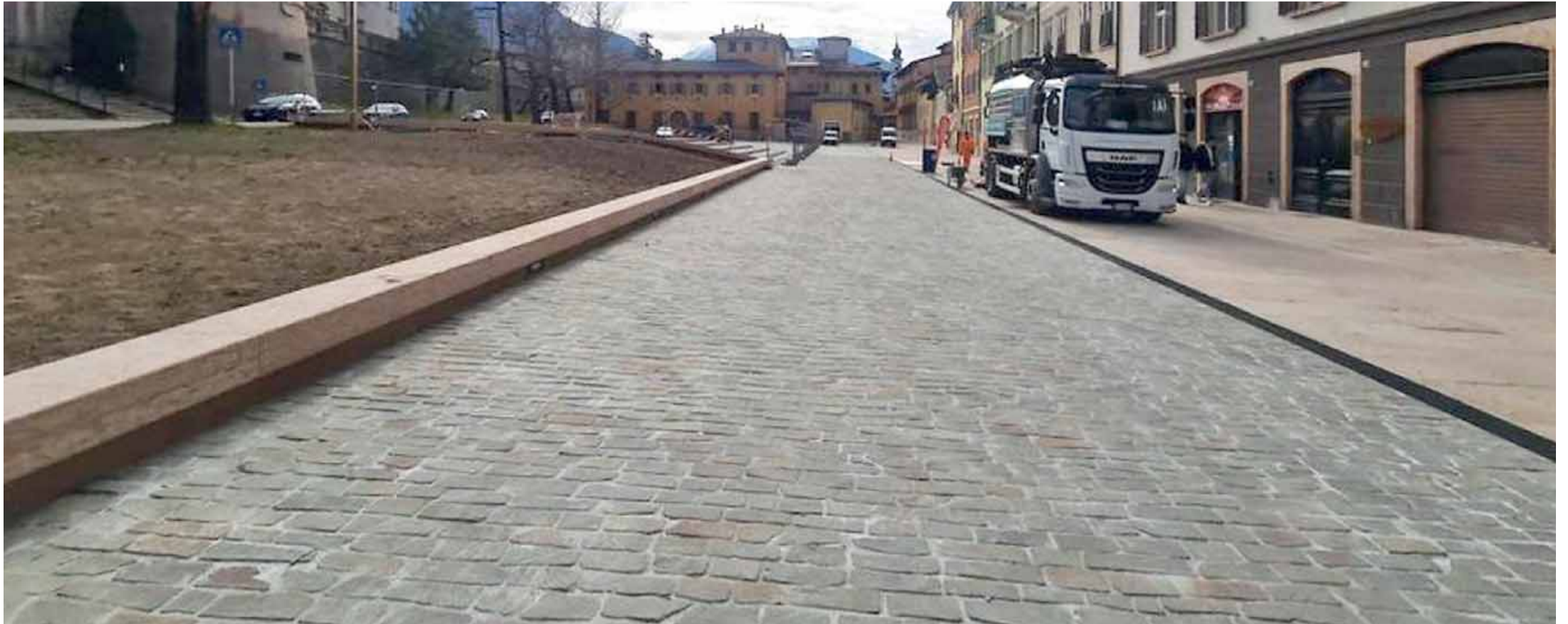
Piazza della Mostra «svelata» dopo i lunghi lavori: ha una ampia pavimentazione in porfido. «Ma il progetto vincitore prevedeva invece lastre di cemento» accusa l'architetto Toffolon di Italia Nostra
