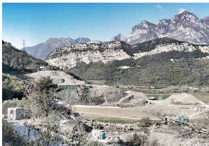
Una veduta della discarica della Maza e del cantiere
