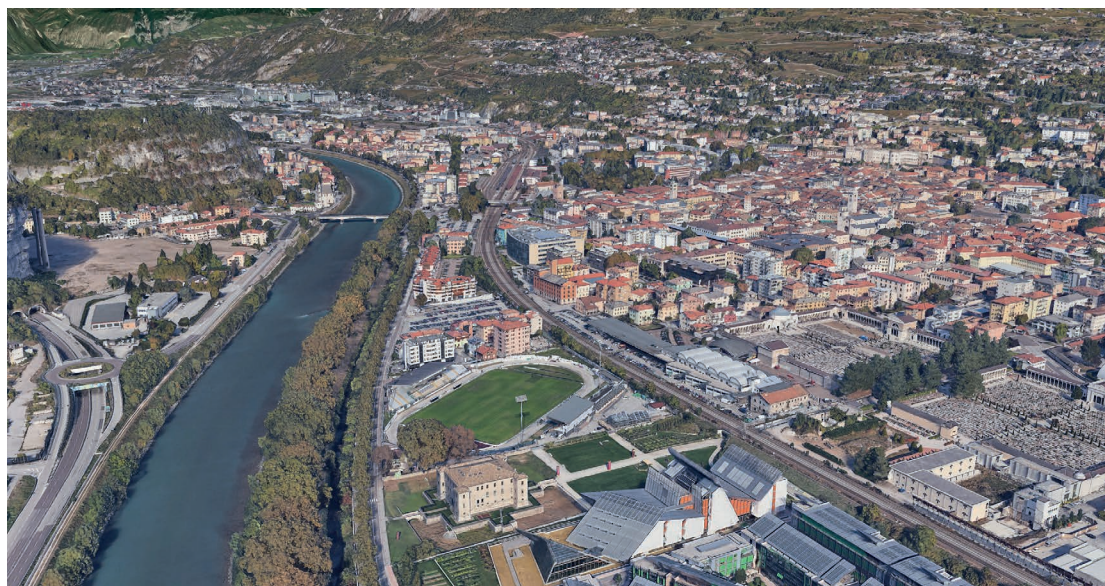
5 La parte centrale della ferrovia storica, da Palazzo delle Albere allo Scalo Filzi, che verrà interrata
