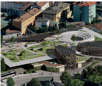
2 L'immensa copertura piana (3400 m 2 ) "truccata" da giardino pensile
