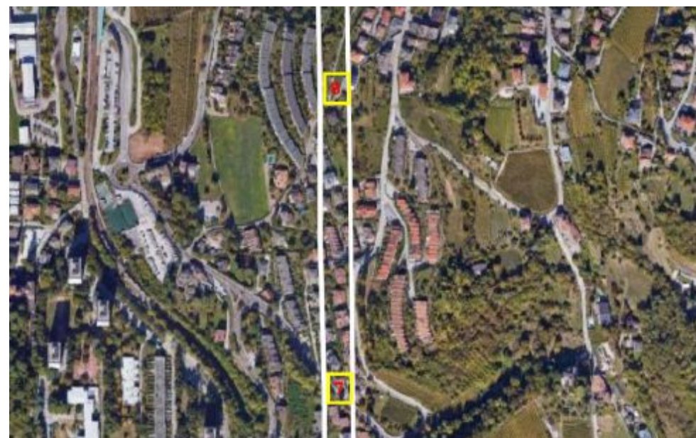
Villazzano Le sedi degli interventi di carotaggio nella parte sud dell'abitato
