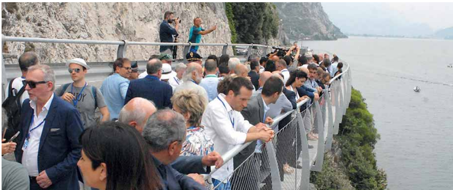
La nuova ciclovía nel tratto di Limone: un hot spot per farsi i «selfie» sul lago, e un manufatto «ingombrante»
