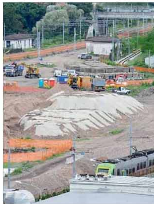
Terreni accumulati e coperti con teloni allo Scalo Filzi
