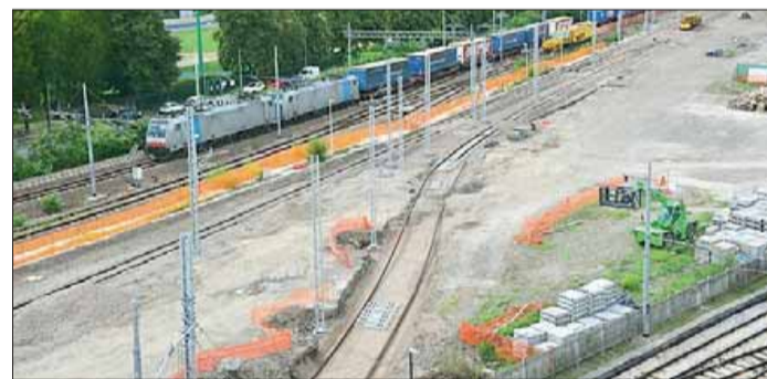
L'area dove saranno provvisoriamente spostati i binari della Trento-Malé
