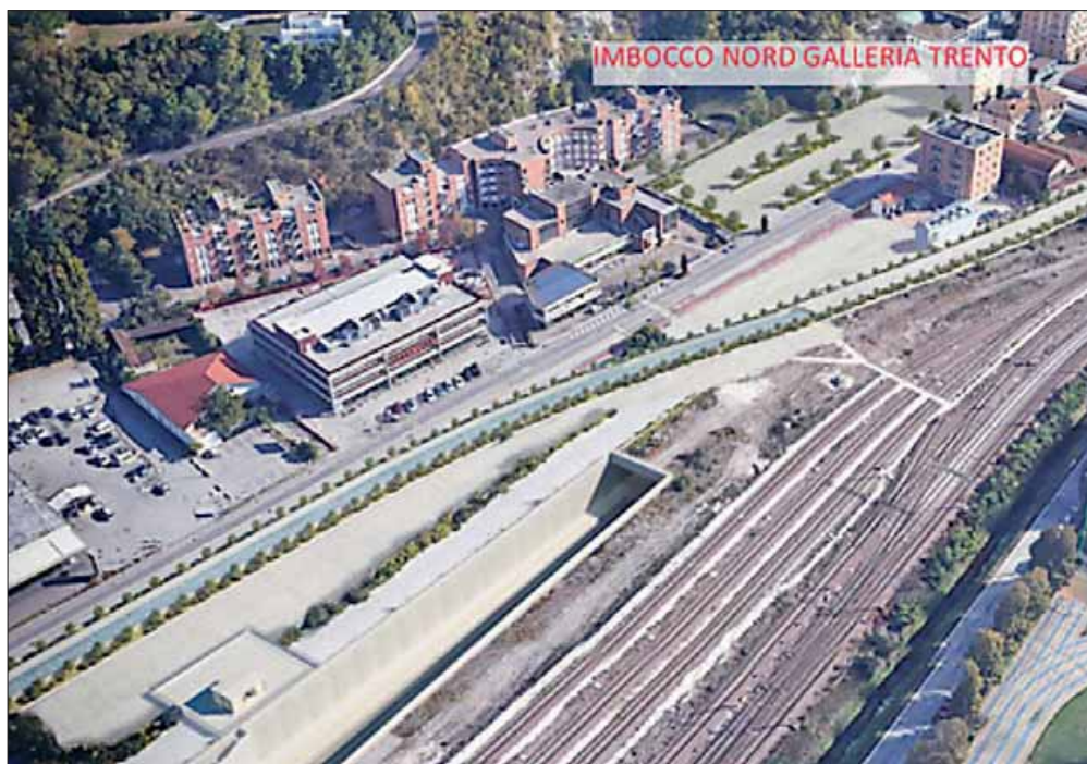
Il rendering che mostra l'uscita a cielo aperto del tracciato all'interno dello Scalo Filzi
