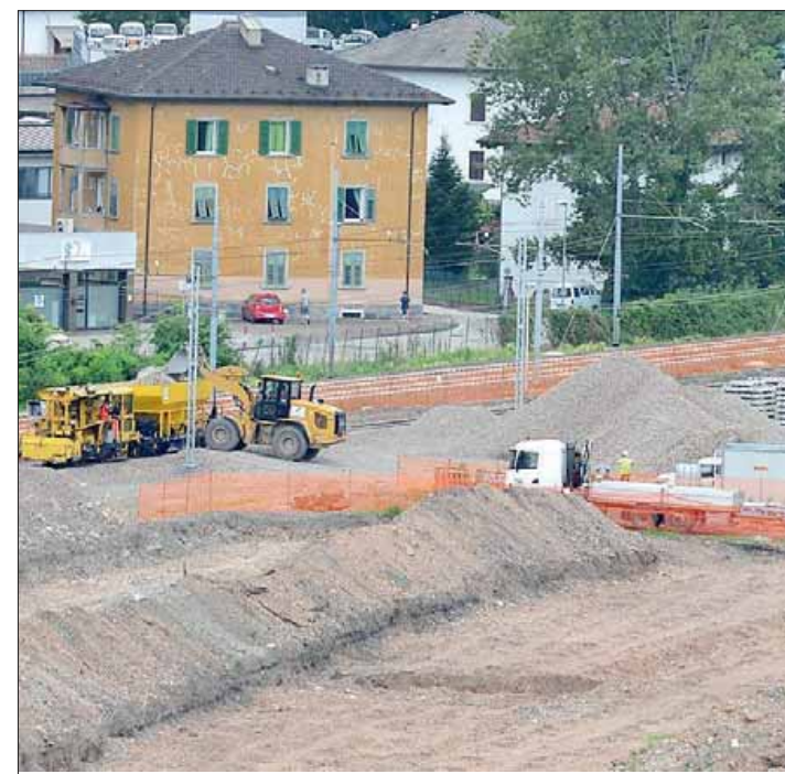
I lavori in corso nell'areale ferroviario
