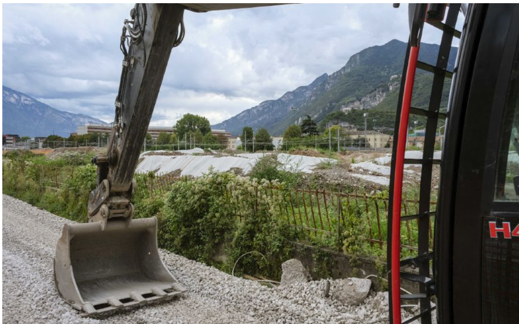
Il cantiere del Bypass. Nei prossimi giorni potrebbe allargarsi l'area messa sotto sequestro dalla Procura. © Foto Federico Nardelli
