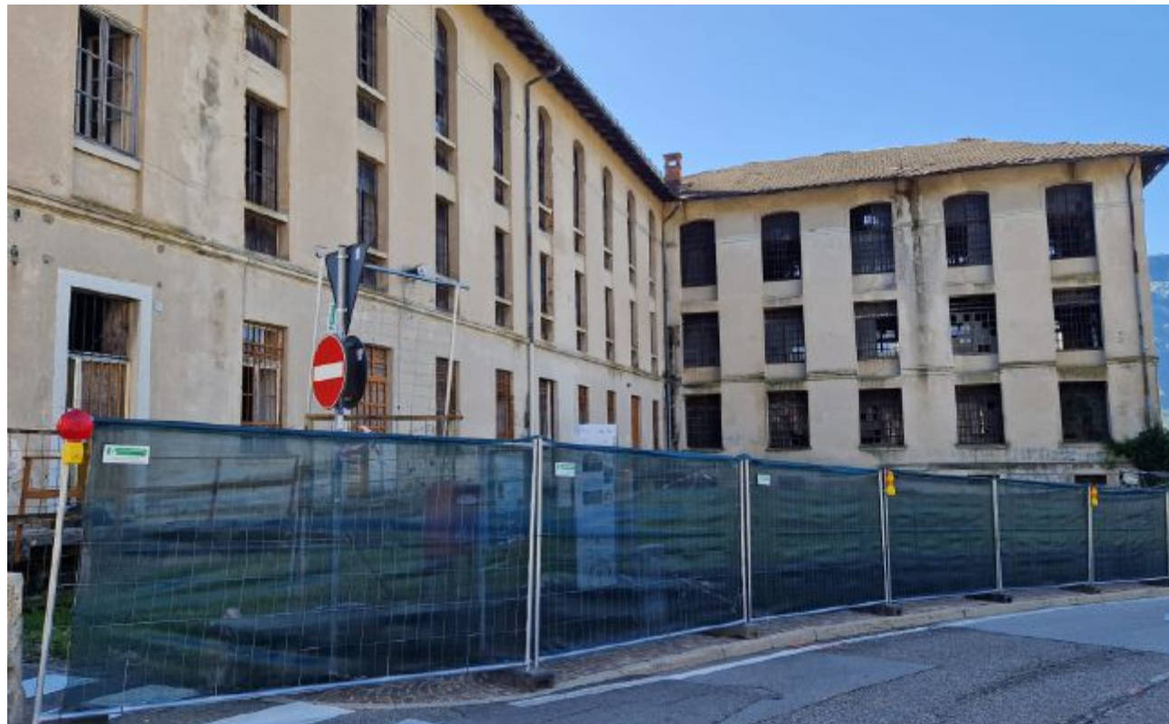
Cantiere La Masera tabacchi è stata recintata in vista della demolizione
