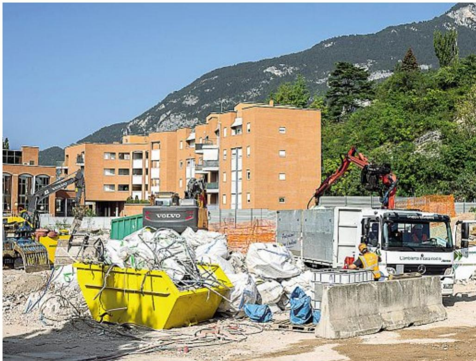
Lavori in corso Operai e mezzi all'opera nei cantieri della circonvallazione ferroviaria, nella zona dell'ex scalo Filzi a Trento
