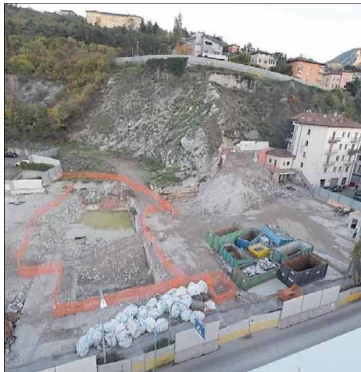
Il cantiere nord del bypass ferroviario
