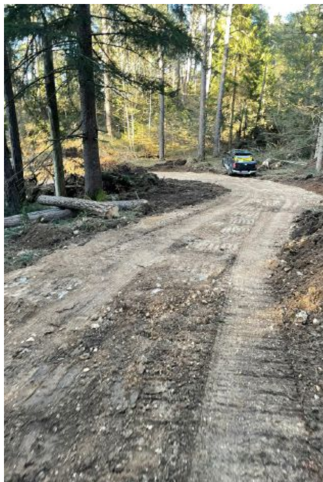
Cantiere I lavori di esbosco per realizzare il primo tratto di ciclopedonale
