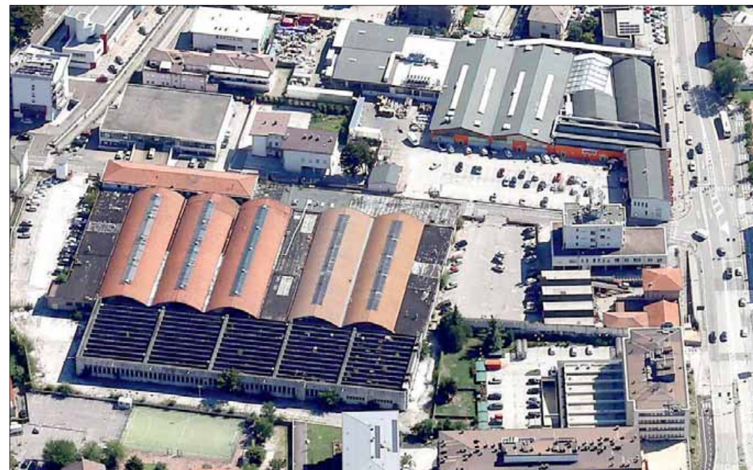
L'area dell'ex Atesina in una panoramica dall'alto: è uno dei nodi della Circoscrizione Centro storico
