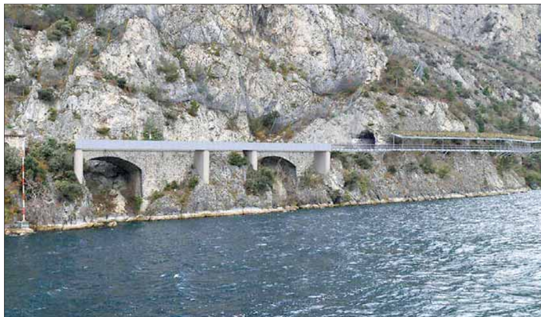
Passerelle a cielo aperto e coperte nel tratto progettato al confine con la provincia di Brescia
