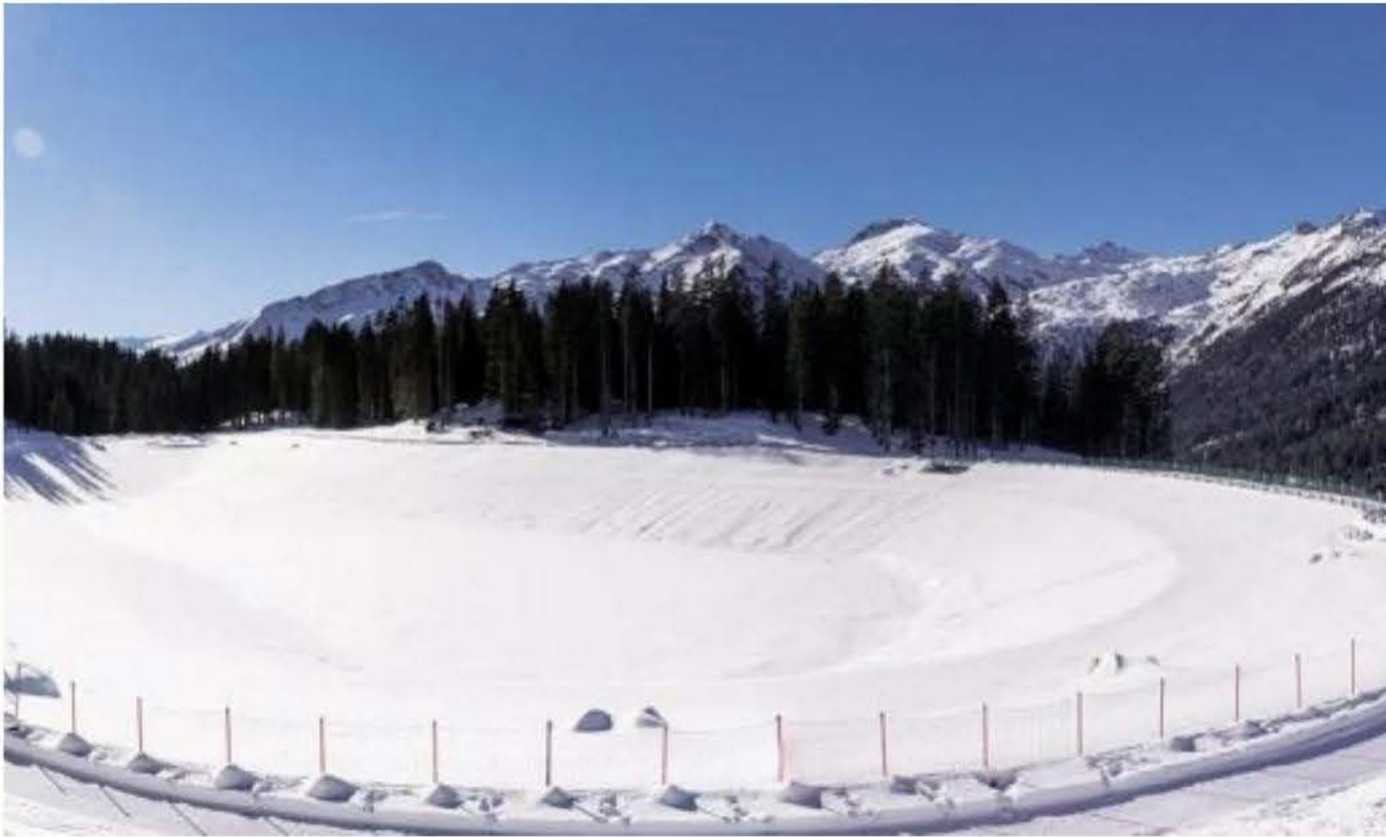
Lago artificiale Il bacino Montagnoli, costato 10 milioni di euro, è tra i più grandi d'Italia e alimenta i 732 generatori di neve di Madonna di Campiglio
