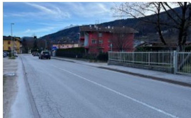
Asse viario Viale Europa è l'arteria che attraversa la frazione
