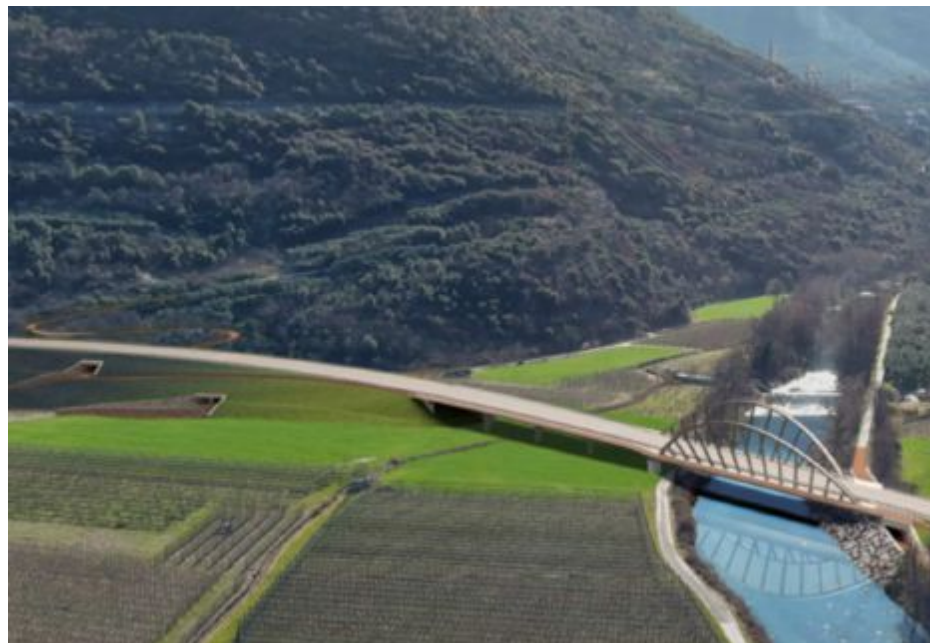
La sezione Il particolare del tomo di terra con i sottopassi, il viadotto con i piloni e il ponte sulla Sarca
