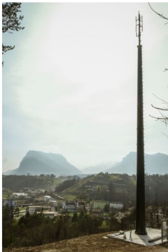
Dominante L'antenna affacciata su Ponte Arche
