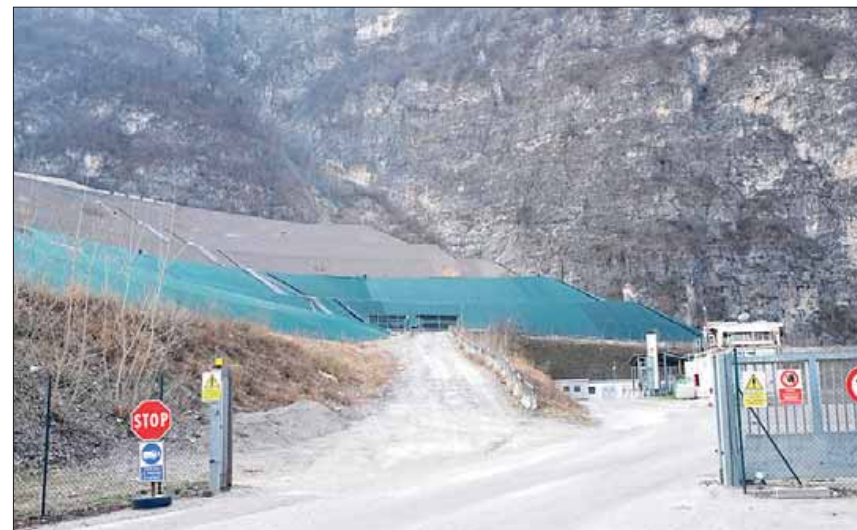
La discarica di Ischia Podetti: è tecnicamente esaurita, in corso i lavori per il nuovo catino
