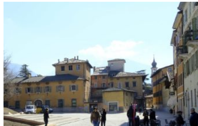
Piazza Mostra L'immobile dell'ex Questura, in stato di abbandono da 20 anni
