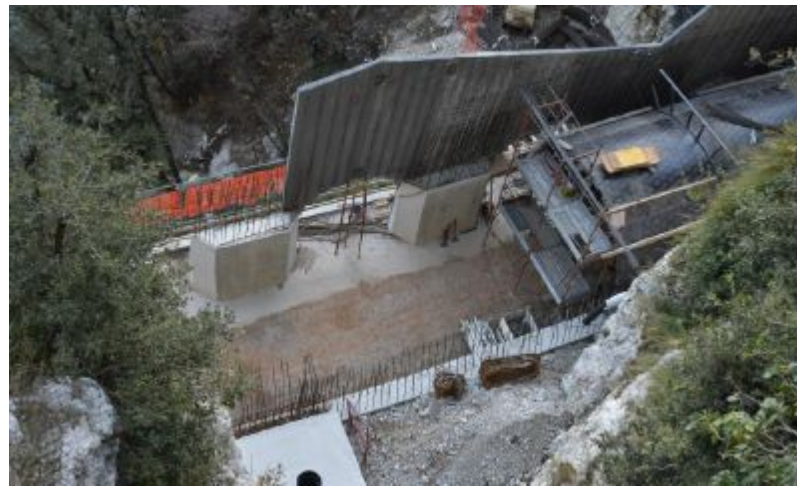
In costruzione Proseguono i lavori della ciclovía sul lato Trentino
