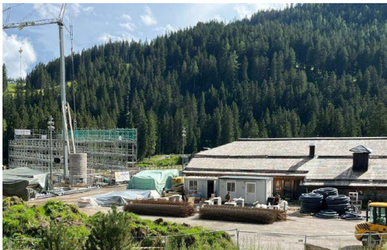
Cantiere Il ponteggio montato nell'area dove verrà realizzato il nuovo après ski
