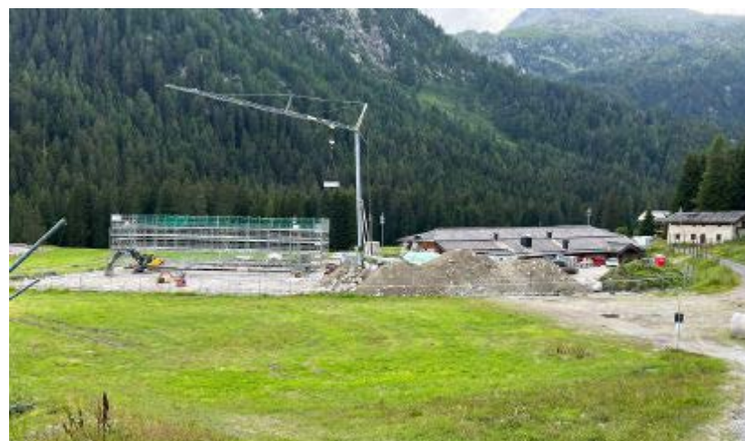
Contestato Il progetto è stato fortemente criticato da Italia Nostra e da un gruppo di residenti
