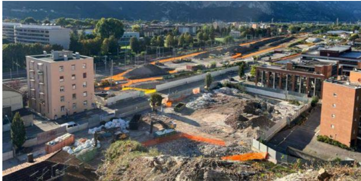
Cantiere nord L'area di via Brennero dove sbucherà la galleria del nuovo bypass ferroviario
