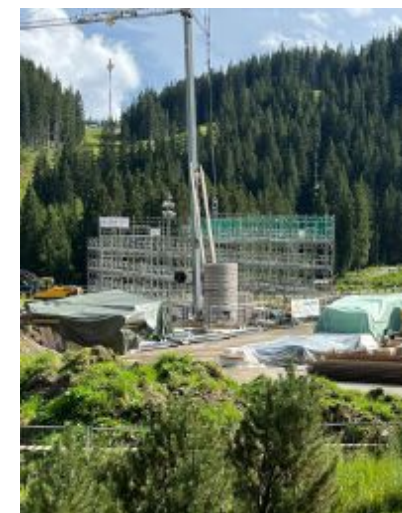
Impatto L'edificio in costruzione, tra i ponteggi
