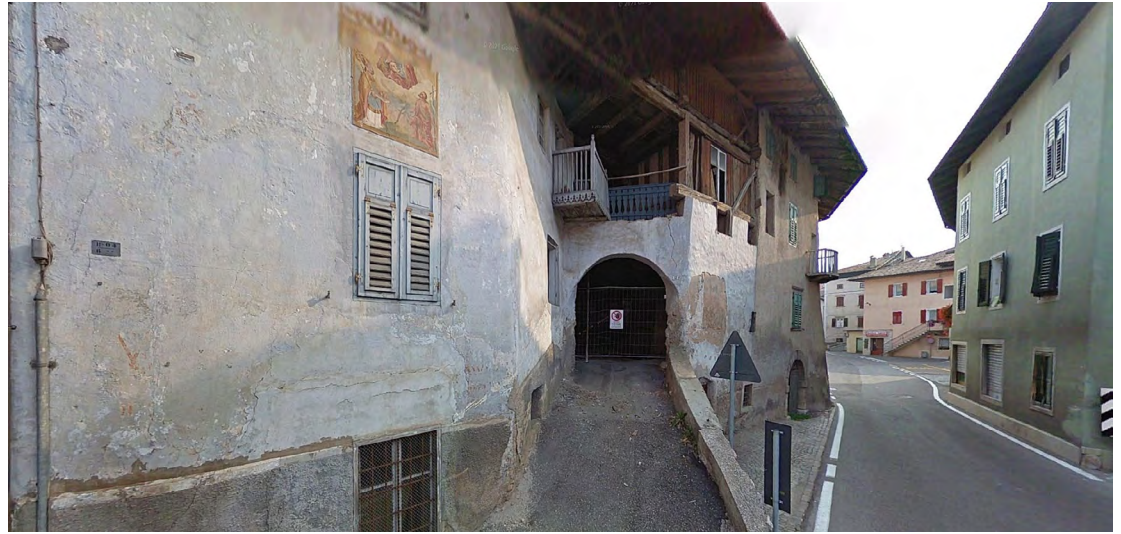
1 Romeno, edificio quattrocentesco prima della demolizione
