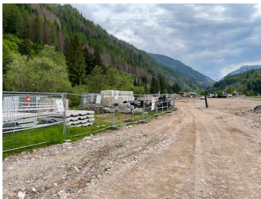
1, 2 Il cantiere della ciclo-pedonale lungo l'Avisio
