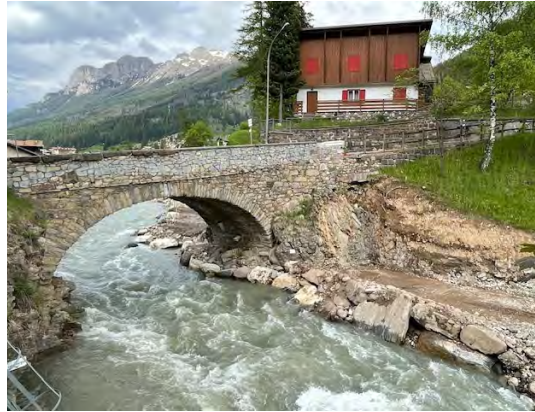
2,3 La spalla sinistra del ponte con l'indicazione dell'ingresso del tunnel
