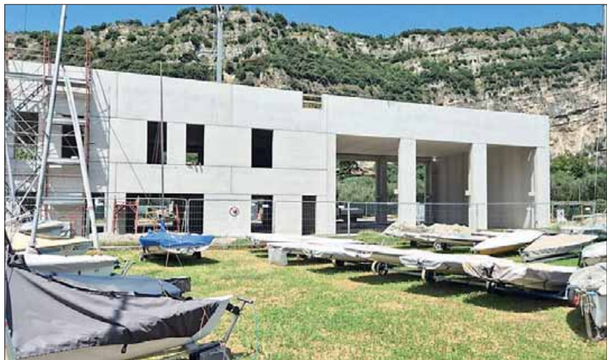
La struttura in fase di ultimazione che ospiterà la nuova sede del Circolo Vela Arco (Bonavida)
