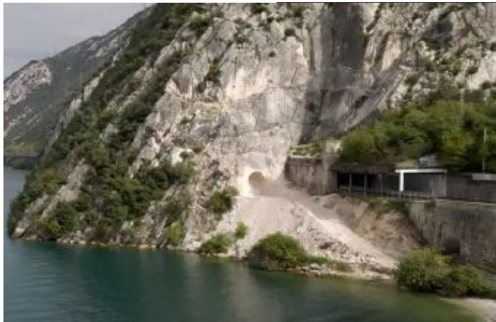
La perforazione L'imbocco della galleria che finirà nel vuoto (gardesana orientale)
