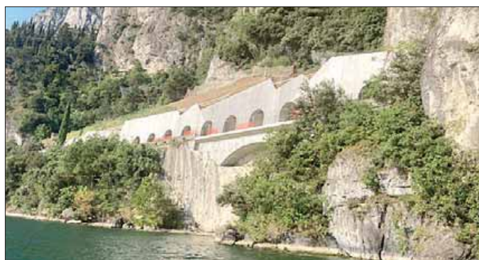
Un tratto di Ciclovia del Garda già costruito nei pressi di Riva
