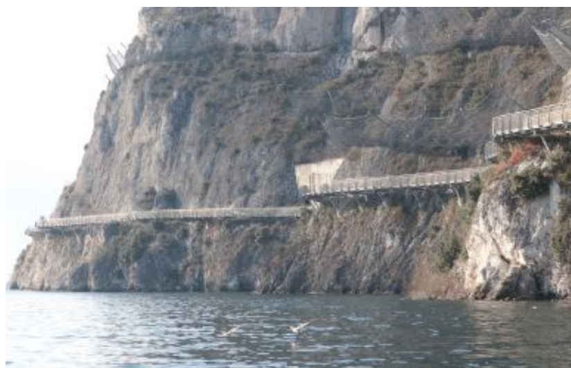
Le barriere Le decine di metri di acciaio paramassi su tutta la falesia © Giorgio Salomon
