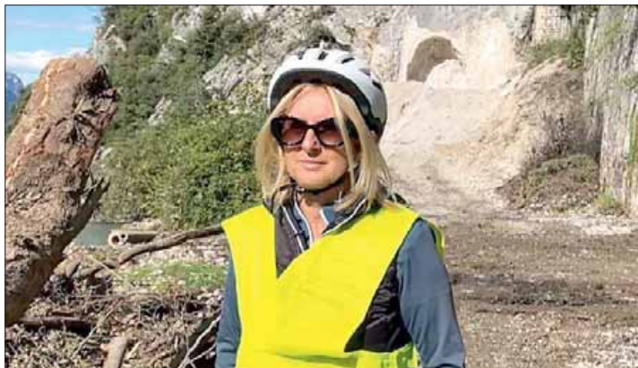
La senatrice di AVS Aurora Florida in sopralluogo al cantiere di Baitone
