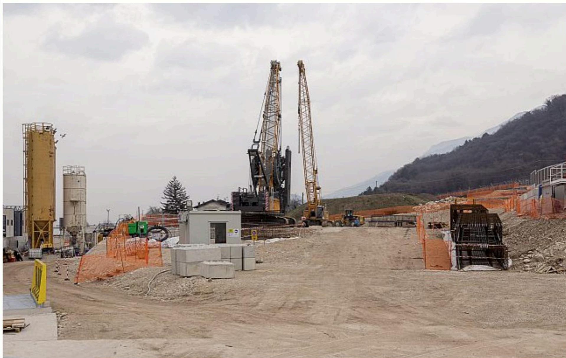
Cantieri I lavori del bypass nella zona di Mattarello
