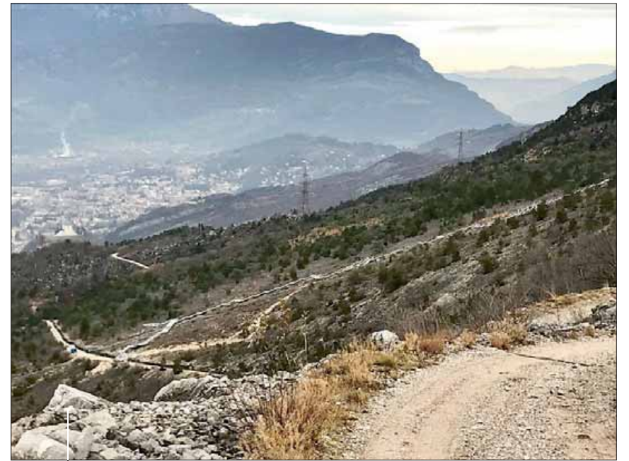
Due immagini, dall'alto e dal basso, della nuova passerella ai Lavini di Marco, che dovrebbe permettere ai futuri visitatori di ammirare le orme dei dinosauri senza rovinarle. La struttura, visibile anche dalla Destra Adige, è molto criticata per l'impatto paesaggistico.
