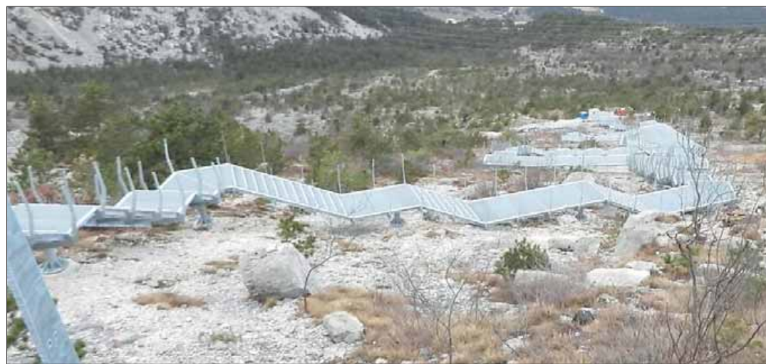
La passerella del percorso di visita alle orme dei dinosauri. In alto l'architetto Claudio Lucchin
