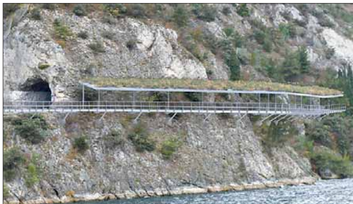
Uno dei progetti di carreggiata a sbalzo per la Ciclovia del Garda
