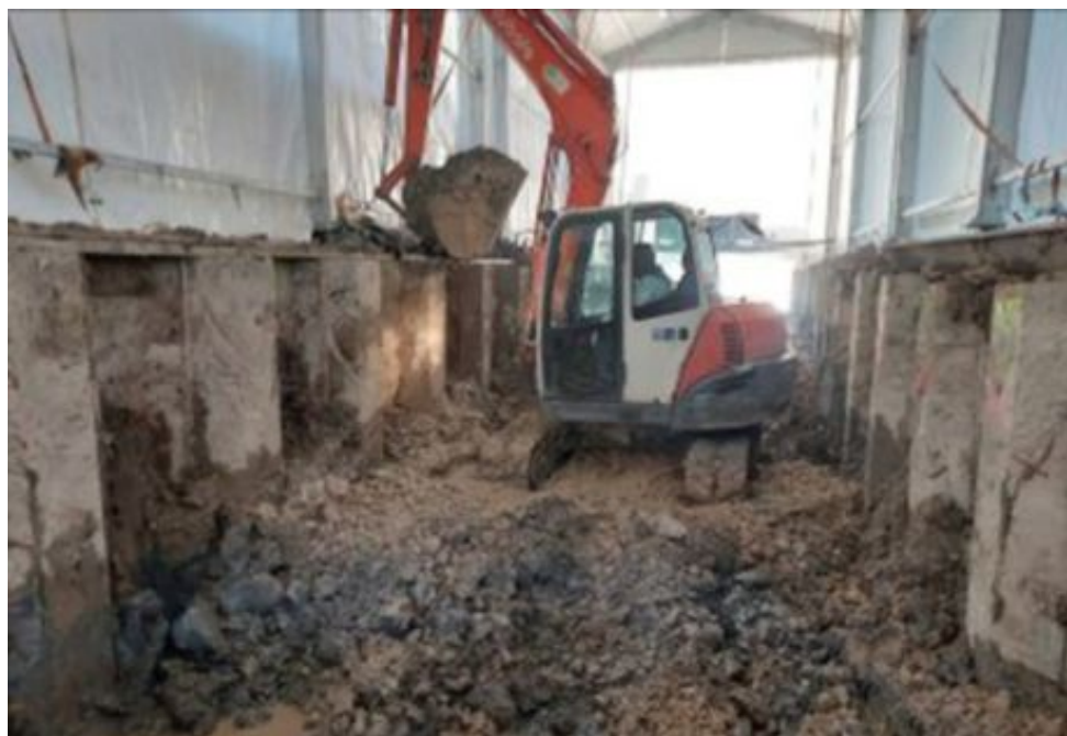
Bonifica I lavori di rimozione del materiale inquinato nelle rogge demaniali, che hanno un'estensione di oltre 6 chilometri
