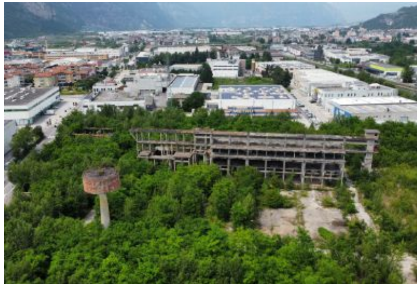
Scheletro industriale Quello che rimane della Sloi, a Trento Nord
