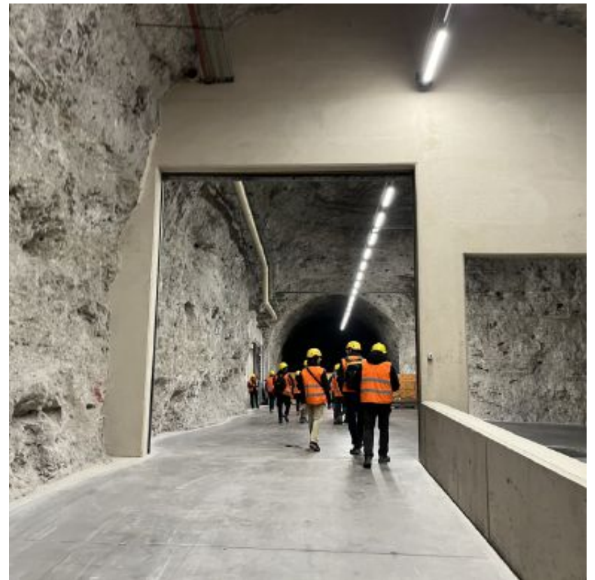
Miniera I corridoi ipogei che, finito lo scavo di dolomia, stanno per ospitare server informatici
