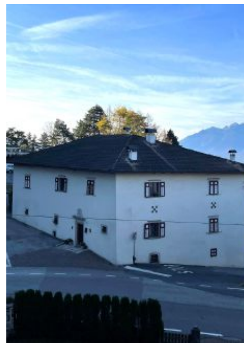
Casa Rizzardi L'edificio oggetto dei lavori
