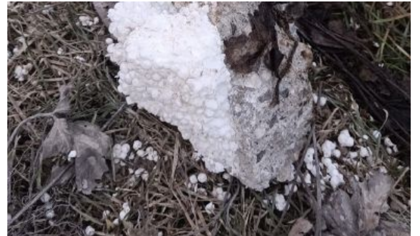
Polistirolo Uno dei tanti pezzi di polistirolo trovati in un'ampia area confinante con il cantiere
