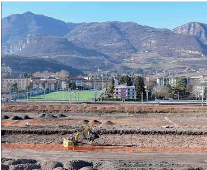
Il cantiere all'ex scalo Filzi per la realizzazione del bypass ferroviario
