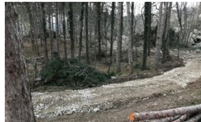
I lavori Tagli di piante, ghiaia di riporto, ruspe in azione
